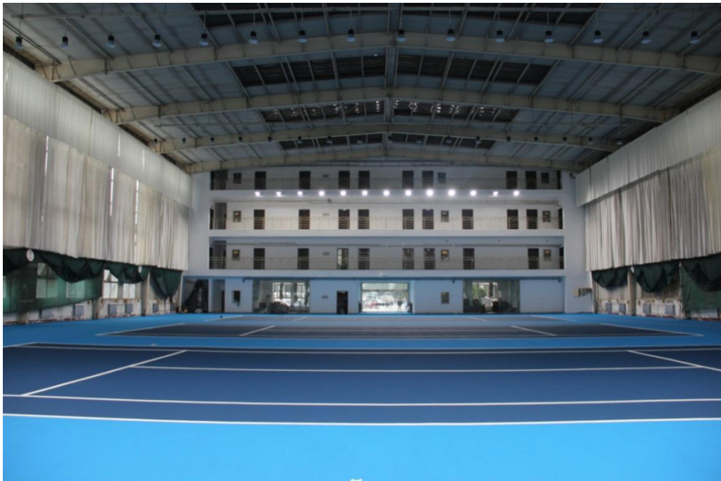
第一室内网球馆维修后照片
