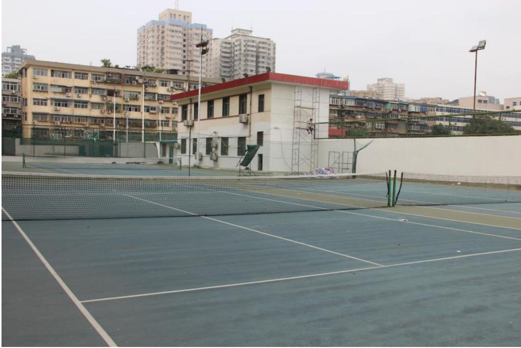
第二室外网球场维修前照片
