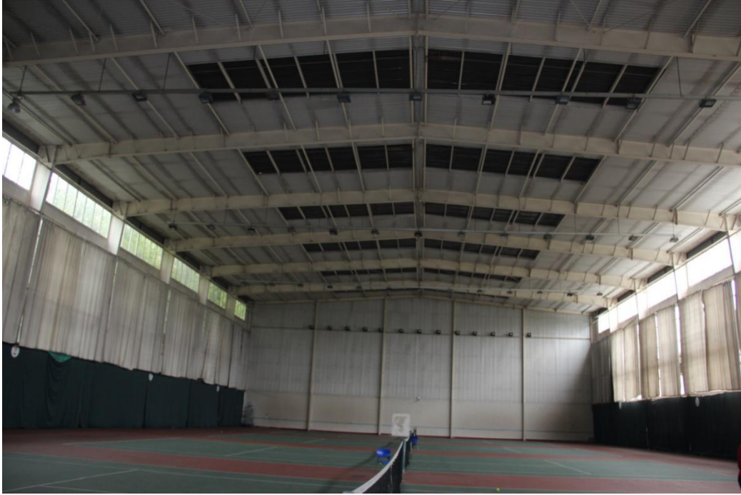
第一室内网球馆维修前照片
